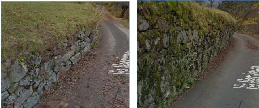
Figura 3.1 – Stato attuale delle murature laterali di contenimento
