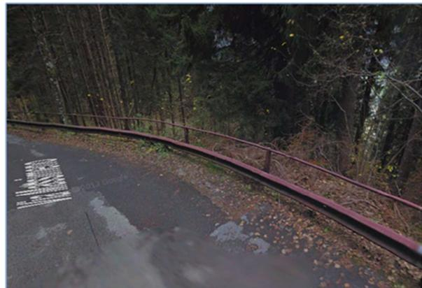
Figura 1.1 – Stato attuale delle barriere di sicurezza
